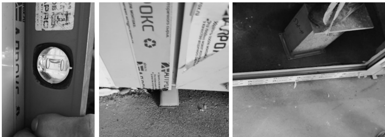
Регулирование положения коробки и фиксация с помощью клиньев
